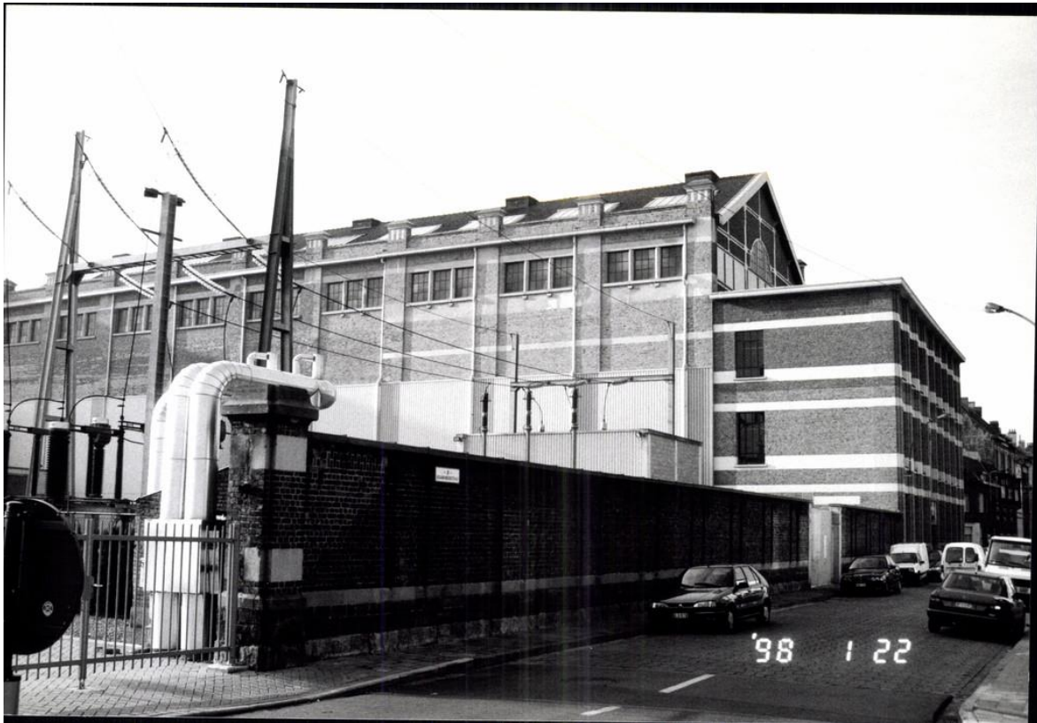
Figuur 37. Turbinezaal electriciteitscentrale S.P.E. 22 jan. 1998. Beeldbank Onroerend Erfgoed.
